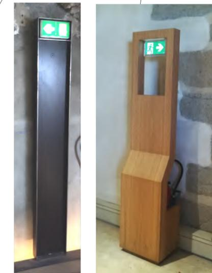
Exemple de totem mis en oeuvre au droit des portes de sortie métallique ou bois - Intégration de l'extincteur à l'arrière du Totem
