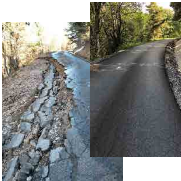
Route du Serpaton, avant et après les travaux
